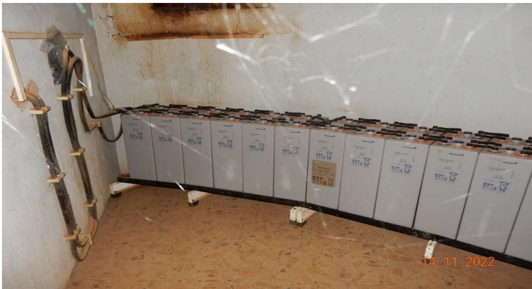
Ansicht neuer Solarbatterien, Foto: Klaus Staffe
